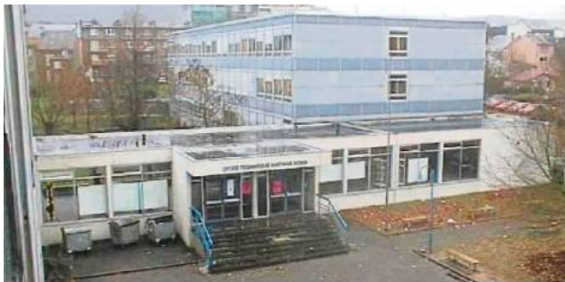
Das mittlerweile abgerissene „Lycée Technique Mathias Adam“. (FOTO: LW-ARCHIV)
